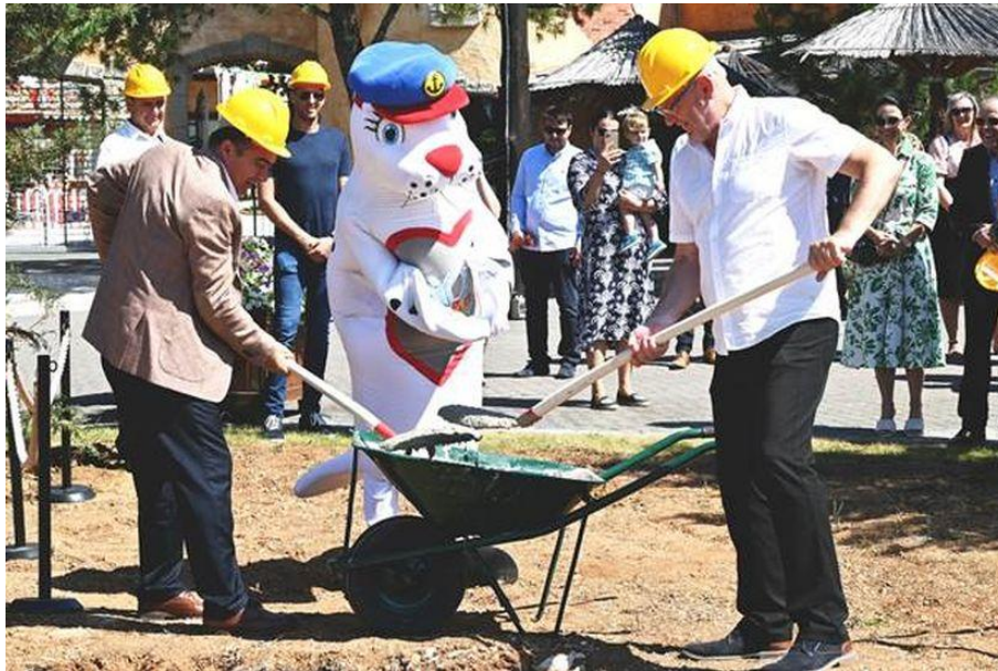
Se están poniendo los cimientos
